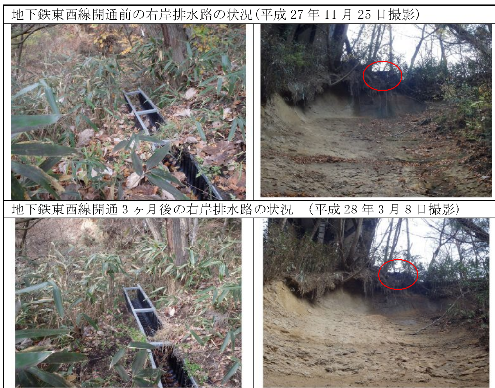
写真 6.1.1-3 (2) 斜面排水路の竜の口溪谷への排水状況 (右岸)
