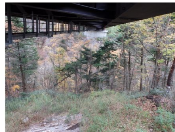
③右岸橋脚前面の状況 前回調査(H26.5.29)から法面植生工箇所の植生が発達し、溪谷への土砂流出を予防している。但し、橋脚直下は、急斜地のため、周辺の法面と比べて植生の発達が遅い。
