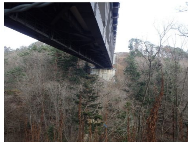
右岸工事箇所全景
