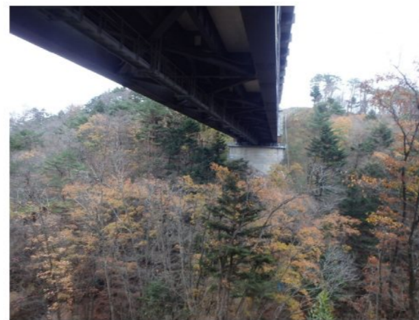
右岸工事箇所全景
