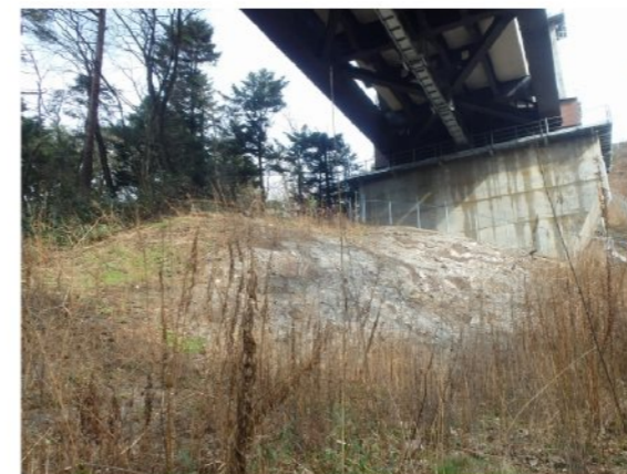
③右岸橋脚前面の状況 前回調査(H27.11.25)から法面植生工箇所の植生が発達し、溪谷への土砂流出を予防している。但し、橋脚直下については、急斜地のため、周辺の法面と比べて植生の発達が遅い。
