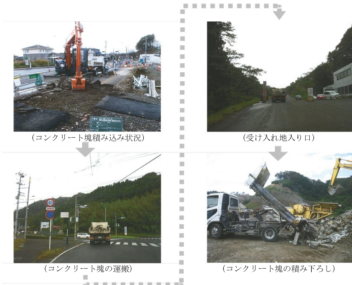
写真 6. 4. 1-1 コンクリート塊の運搬及び再生処理施設の状況
