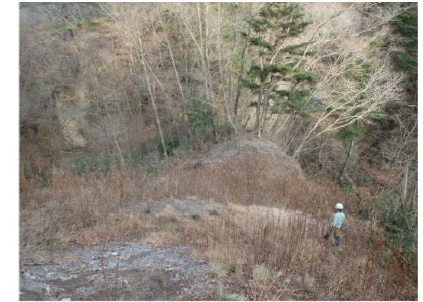
④左岸工事用地下端部 前回調査(H27.11.25)から法面植生工箇所の植生が発達し、溪谷への土砂流出を予防している。
