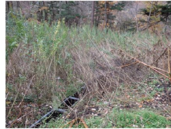
①右岸工事用地下端部 前回調査(H26.5.29)から法面植生工箇所の植生が発達し、溪谷への土砂流出を予防している。
