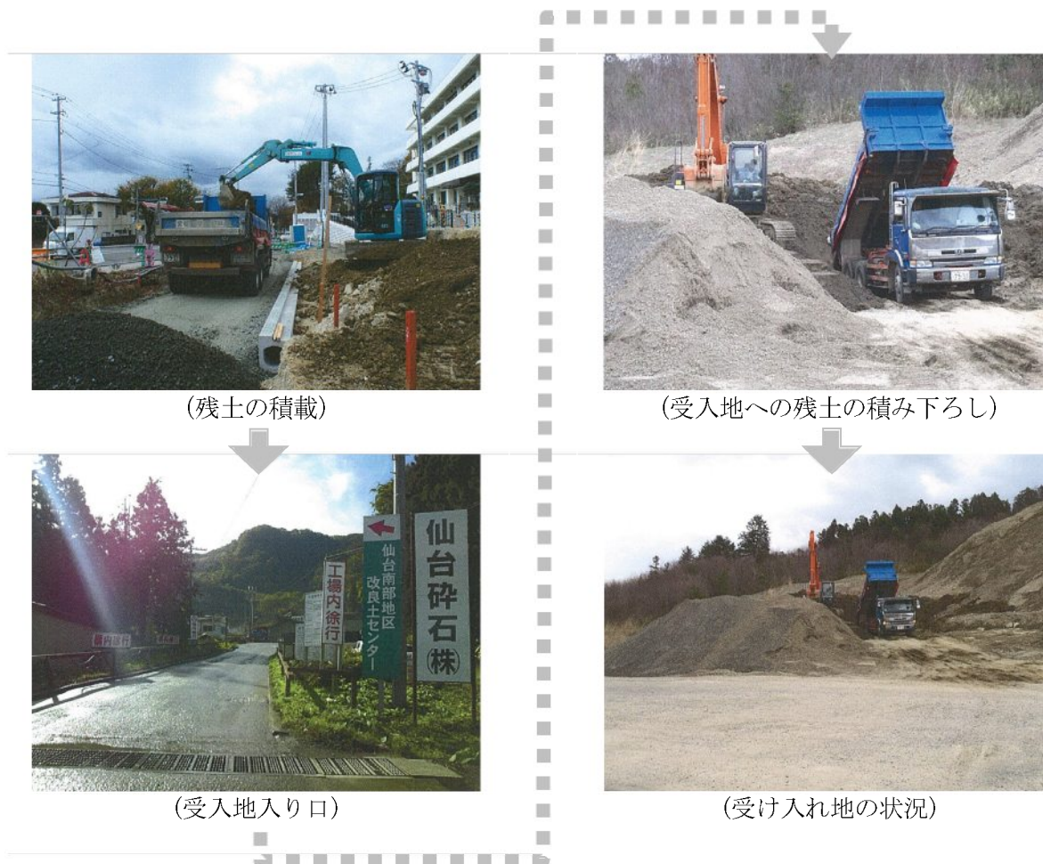
写真 6. 4. 2-1 残土の運搬及び受入地の状況
