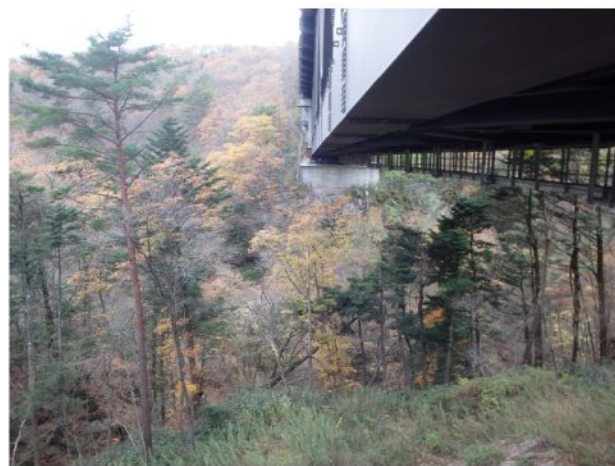
左岸工事箇所全景
