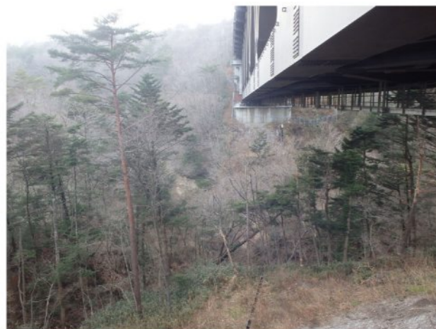
左岸工事箇所全景
