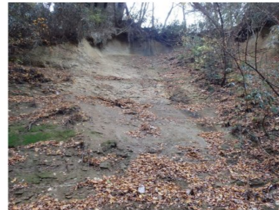
②右岸工事用地下端部の下 溪岸の状況 右岸斜面排水路より排水が行われているが、浸食等は生じていない。オーバーハングで不安定な地形だが前回調査(H26.5.29)から新たな崩壊は発生していない。
