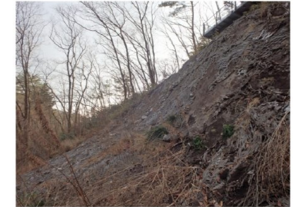
⑤左岸橋脚前面の状況 前回調査(H27.11.25)から法面植生工箇所の植生が発達し、表層のガリー浸食 ※1 による土砂流出を防止している。但し、橋脚直下は、急斜地のため、周辺の法面と比べて植生の発達が遅い。
