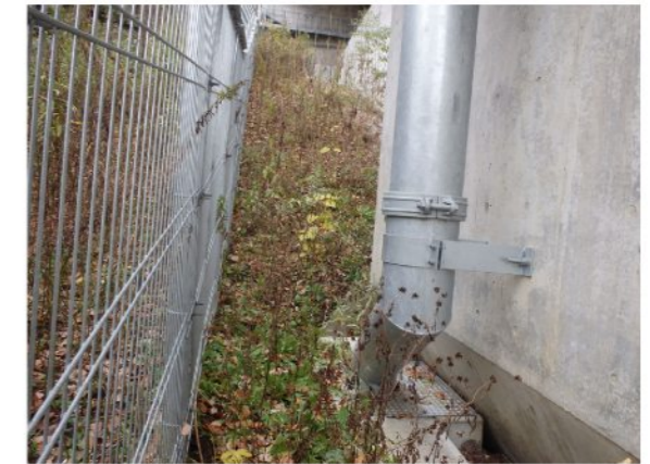
⑥左岸橋脚上流側面 前回調査(H26.5.29)から排水路周辺の斜面の法面植生工箇所の植生が発達し、溪谷への土砂流出を予防している。
