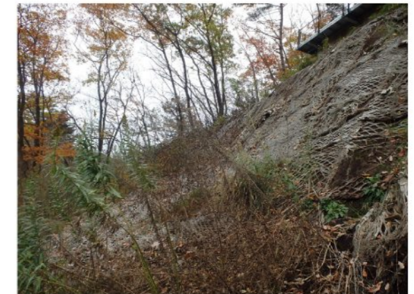
⑤左岸橋脚前面の状況 前回調査(H26.5.29)から法面植生工箇所の植生が発達し、表層のガリー浸食 ※1 による土砂流出を防止している。但し、橋脚直下は、急斜地のため、周辺の法面と比べて植生の発達が遅い。
