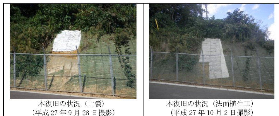
写真 6.2.3-2 法面の崩落箇所の復旧状況
