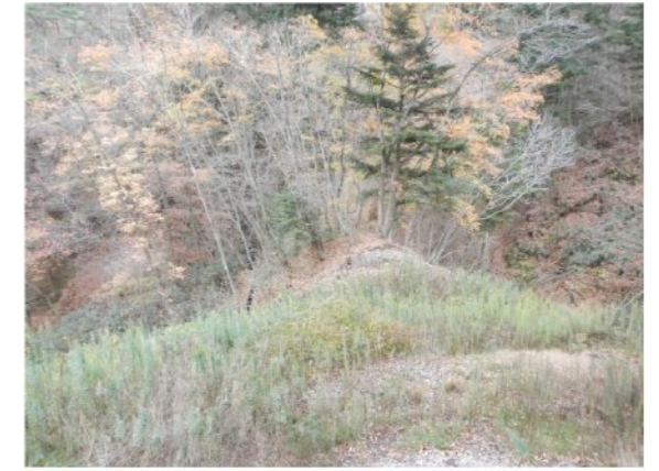
④左岸工事用地下端部 前回調査(H26.5.29)から法面植生工箇所の植生が発達し、溪谷への土砂流出を予防している。
