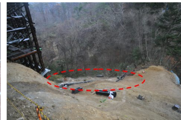
④左岸工事用地下端部 木柵と土嚢により、溪谷への土砂流出を予防している(H24.12.26 と変化なし)。
