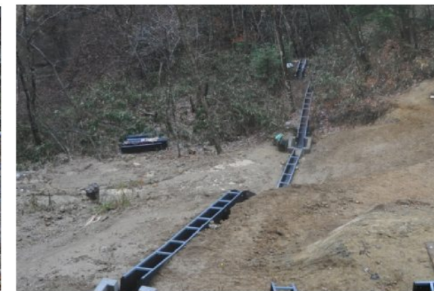
⑥左岸工事用地法面 法面排水工を施工中である。
