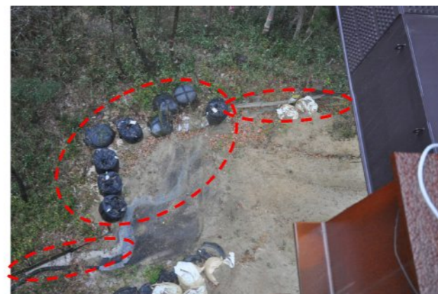
①右岸工事用地下端部 木柵と大型土嚢により、溪谷への土砂流出を予防している(H24.12.26 と変化なし)。
