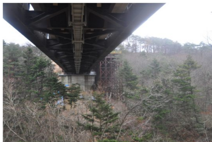
右岸工事箇所全景
