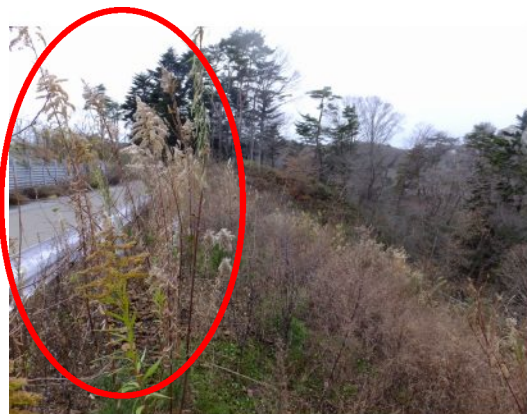
写真-1 セイタカアワダチソウ （補強土擁壁の天端部）
