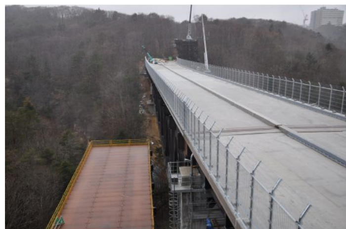
左岸工事箇所全景
