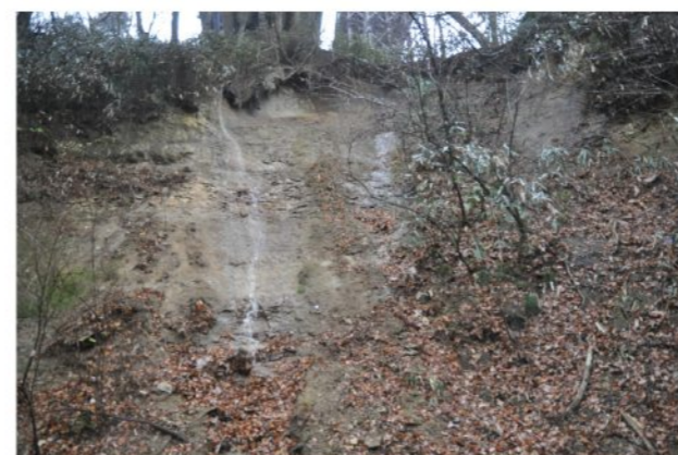
②右岸工事用地下端部の下 溪岸の状況 工事用地からの土砂流下や排水流出跡は認められない。オーバーハングで不安定な地形だが新たな崩壊は発生していない(H24.12.26 と変化なし)。
