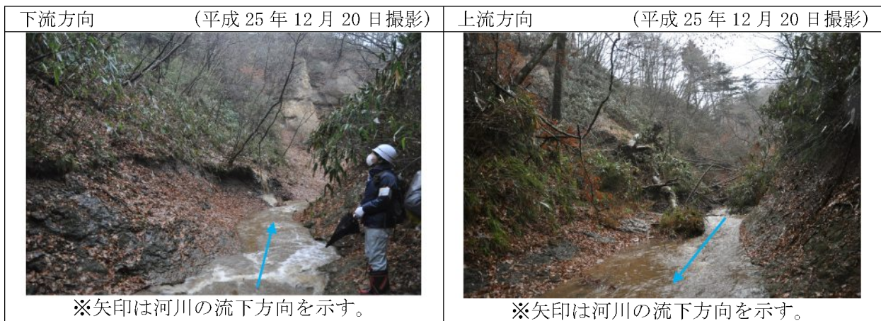
写真6.1.1-2 工事箇所直下の竜の口溪谷河床部の状況
