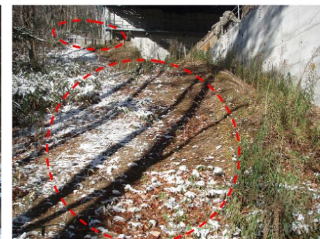
⑥左岸工事用地上流側面 木柵とむしろで表層土砂の流出を予防している。
