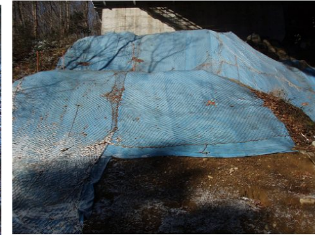
⑤左岸橋脚前面の状況 シートとネットで表層のガリー浸食 ※1 による土砂流出を防止している。
