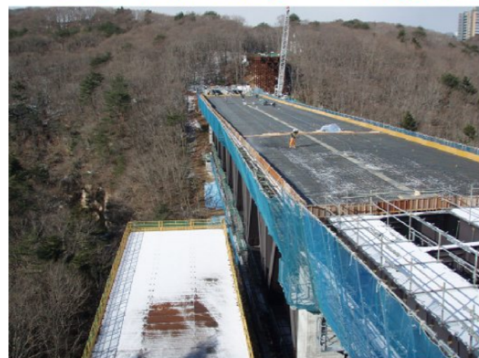
左岸工事箇所全景
