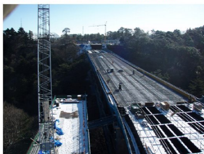
右岸工事箇所全景
