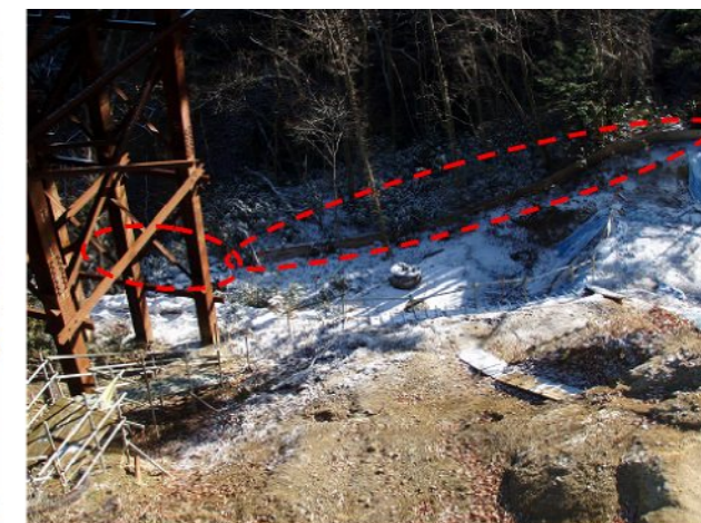
④左岸工事用地下端部 木柵と土嚢により、溪谷への土砂流出を予防している。
