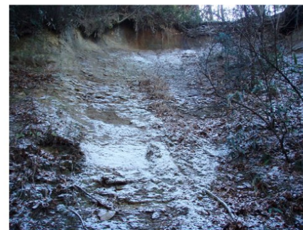
②右岸工事用地下端部の下 溪岸の状況 工事用地からの土砂流下や排水流出跡は認められない。オーバーハングで不安定な地形だが新たな崩壊は発生していない。
