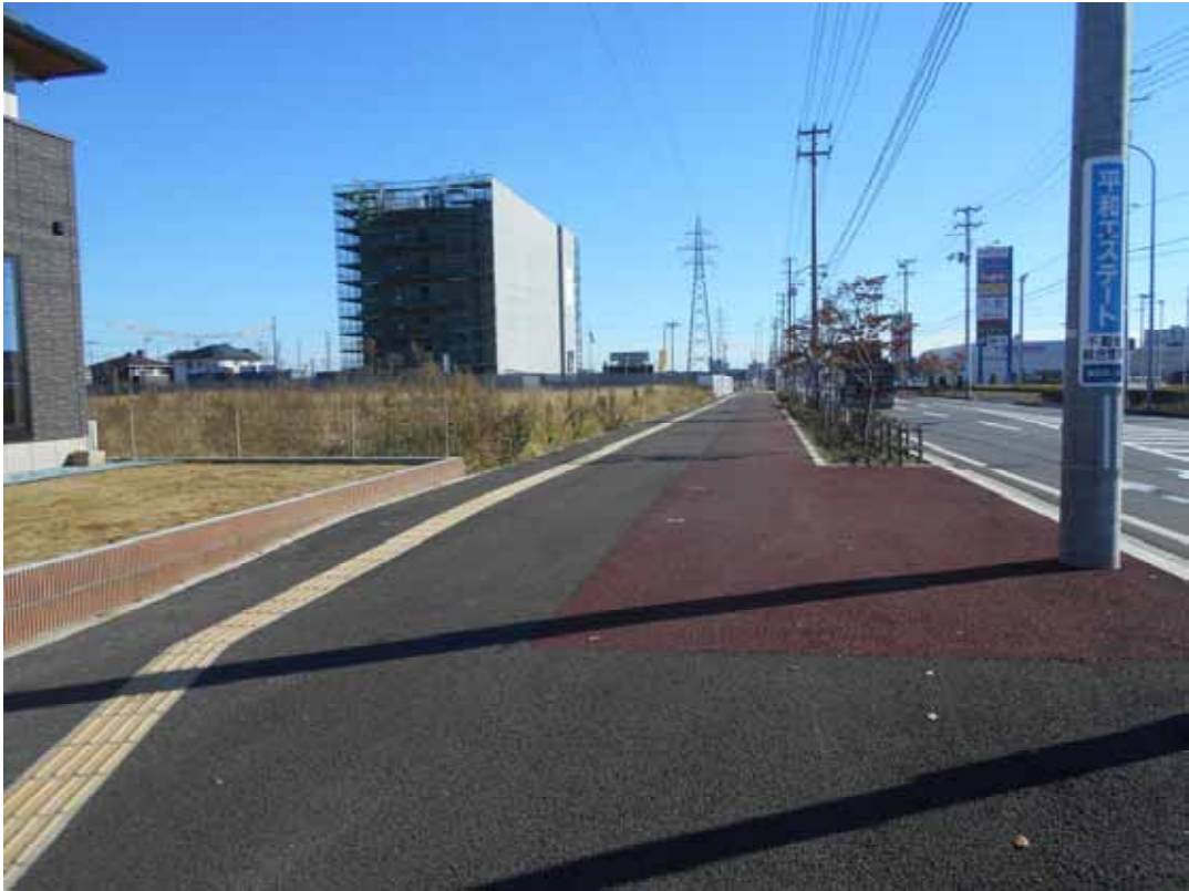
写真4.6-1(2) 完成状況(市道富沢山田線北側)
