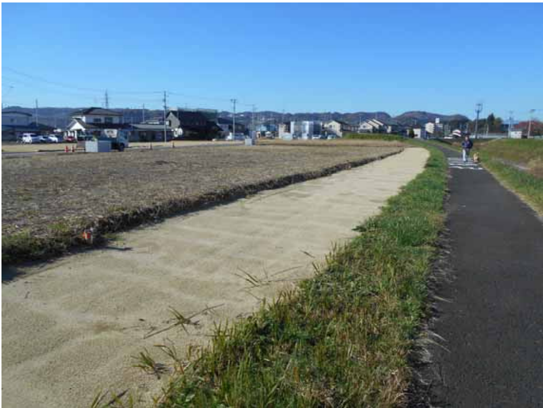
写真4.6-1(3) 完成状況(笹川南側)
