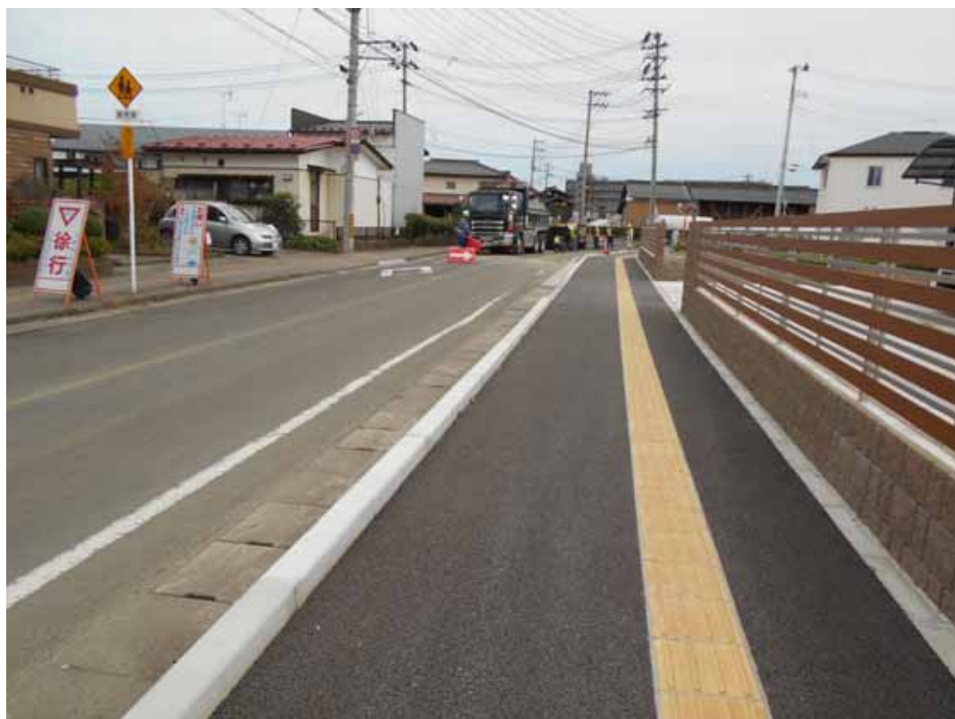
写真4.6-1(1) 完成状況(東側既存市街地と隣接)
