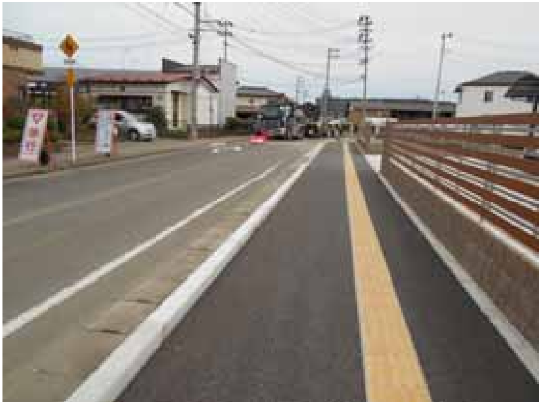
写真4.6-1(1) 3工区の完成状況(東側既存市街地と隣接)
