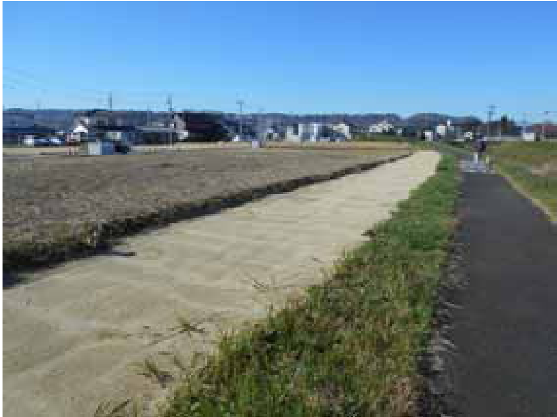
写真4.6-1(3) 5工区の完成状況(笹川南側)
