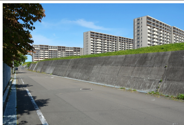
地点Ⅲ：鶴ヶ谷 15 号線(工事完了後:展葉期)
