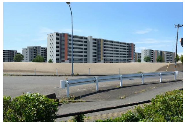
地点Ⅳ：鶴ヶ谷東二丁目公園(工事完了後:展葉期)
