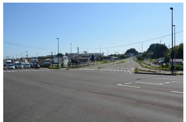
地点Ⅴ：鶴ヶ谷交差点(工事完了後:展葉期)
