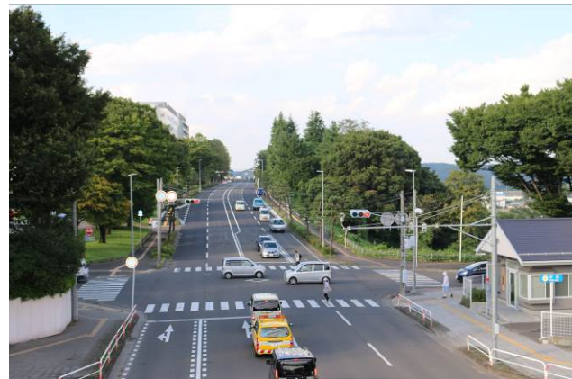
⑥団地内中央の幹線道路（市道 東仙台泉(その2)線）
