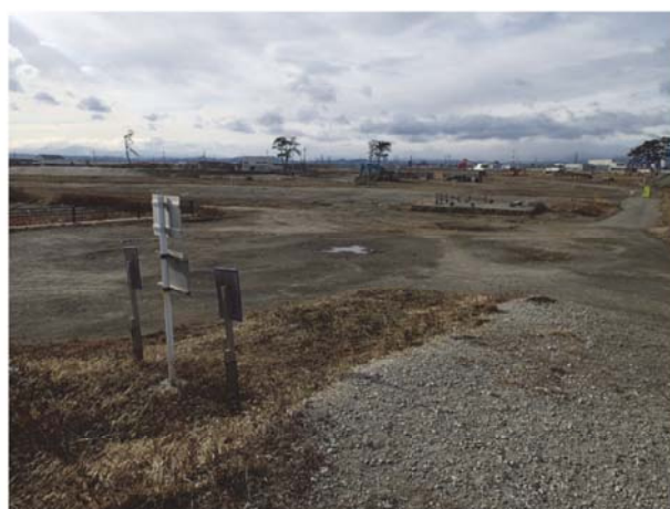
④ 日和山周辺工事状況
