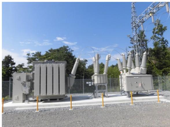
図 2.5-4 送変電設備及び門型鉄構（イメージ）
