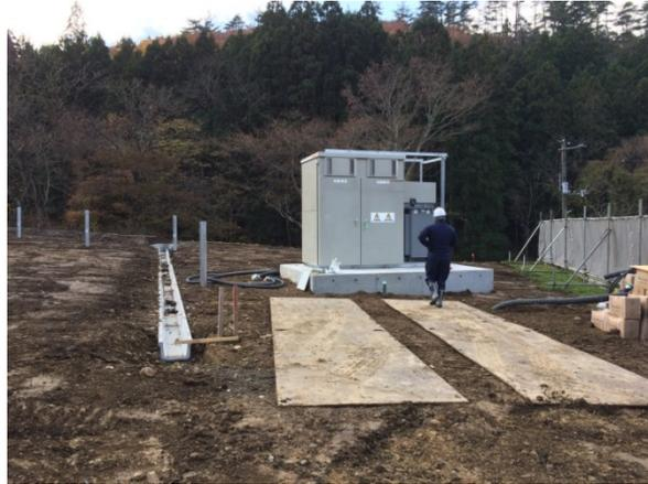
図 2.5-3 パワーコンディショナー及びサブ変電設備（イメージ）
