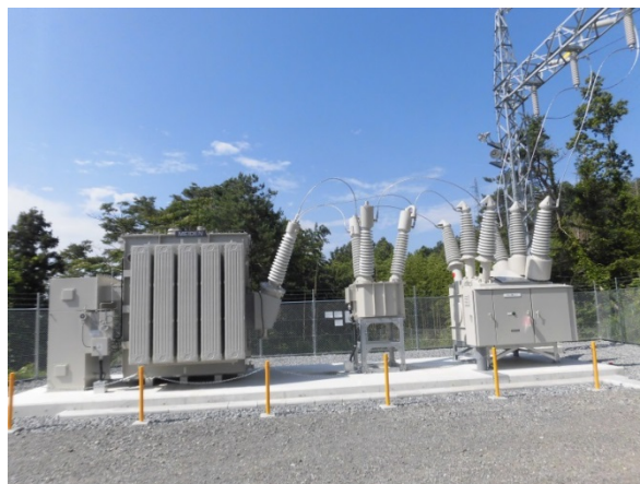
図 1.6-4 送変電設備及び門型鉄構（イメージ）
