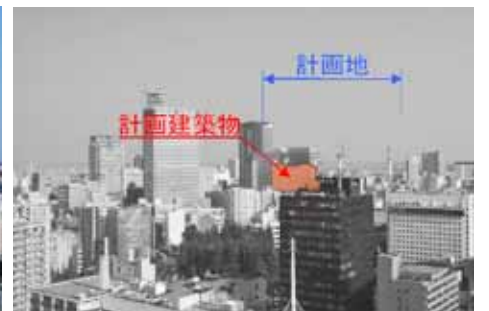
(建築物の視認状況)
