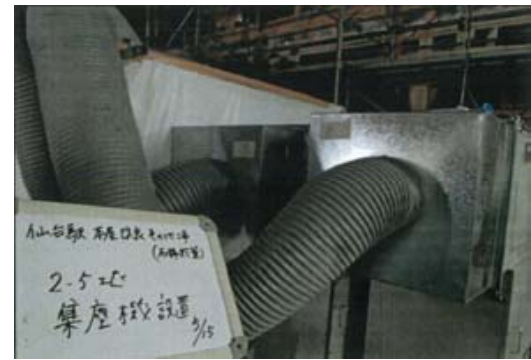
集じん機設置状況
