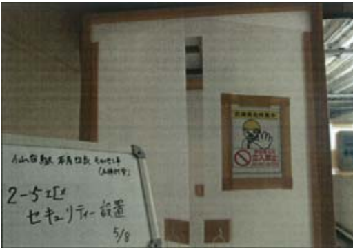
前室設置状況
