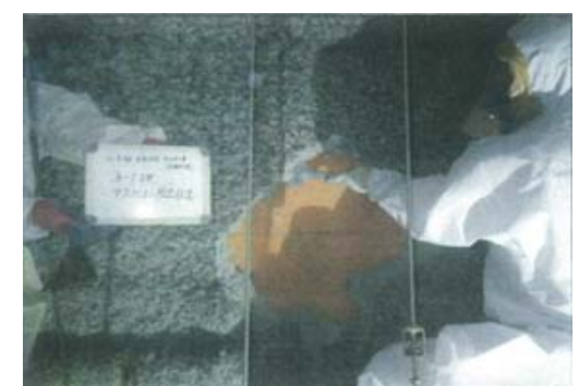
石綿除去作業
