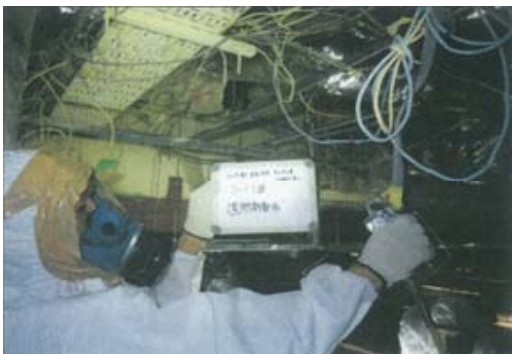
湿潤材散布状況
