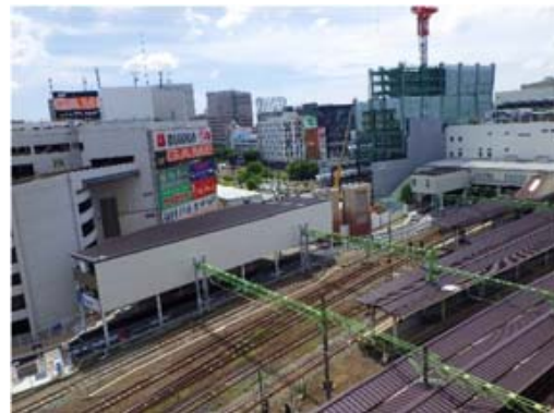
駅屋上からの状況(東口)
