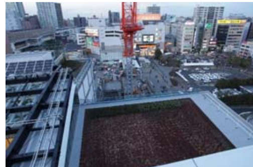
東西自由通路屋根部分
