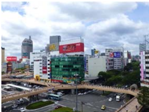
駅屋上からの状況(西口)
