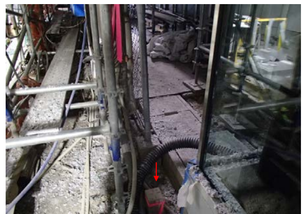
地点⑥（今回測量時：東側より撮影）
