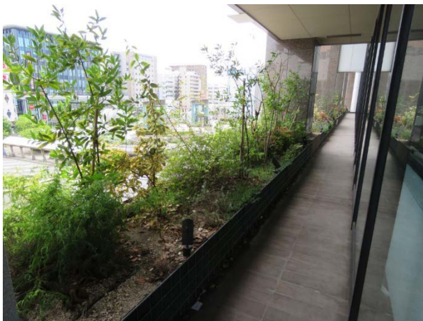
ホテル棟テラス東側（北側から南方向）
