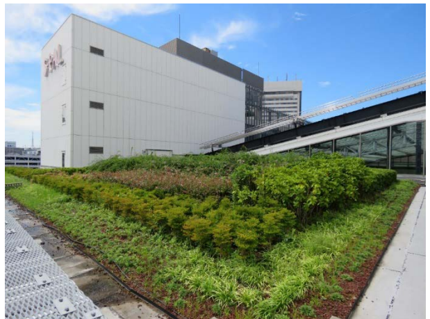
東西自由通路屋根部分
