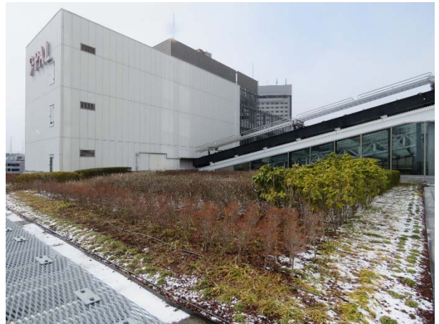
東西自由通路屋根部分
