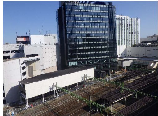
④駅屋上からの状況(東口)
