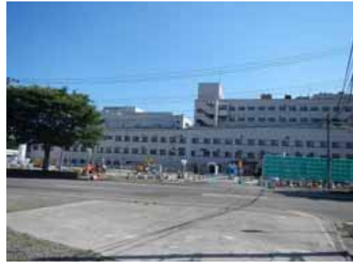
現病院の状況(北側)
