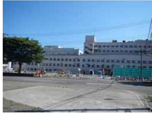
現病院の状況(北側)
