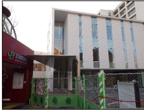
写真 1.4-1 キャノピー設置状況(平成 31 年 1 月 25 日撮影)
