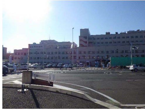
② 建替前の病院の状況 (北側)
