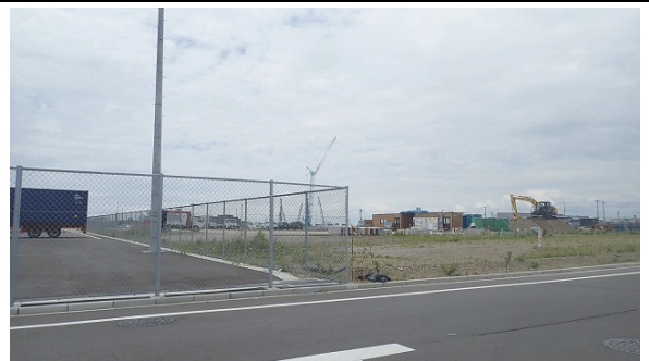
⑧計画地北東端より南西方向
