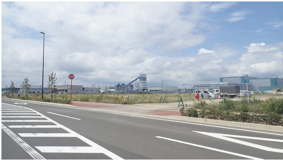
①計画地南東端より北西方向
