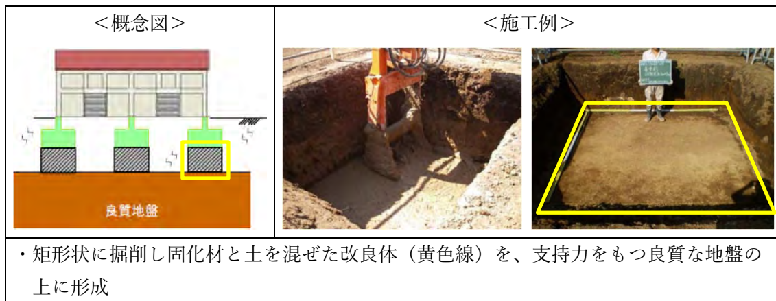
図 1.8-1 地盤改良工事のイメージ
