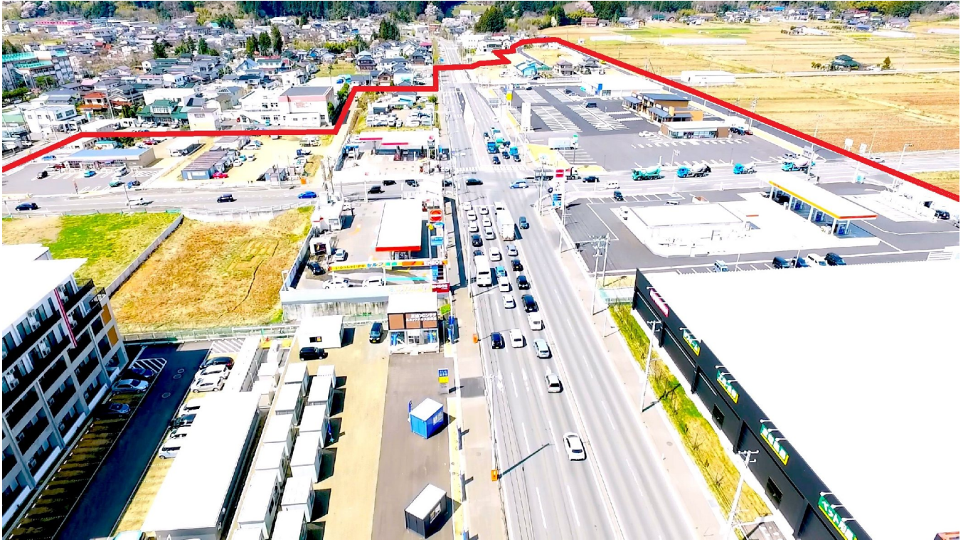
ドローンによる空撮 5 月（事業区域中央上空から西方を望む）
