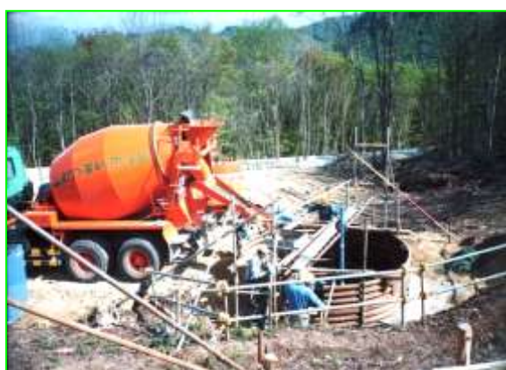
鉄塔工事－基礎工事
