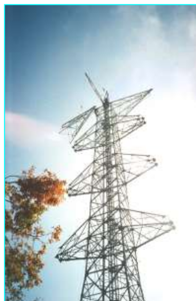
鉄塔工事－組立工事
