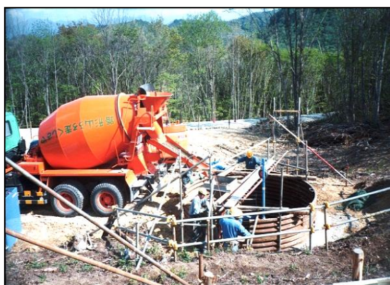
鉄塔工事－基礎工事
