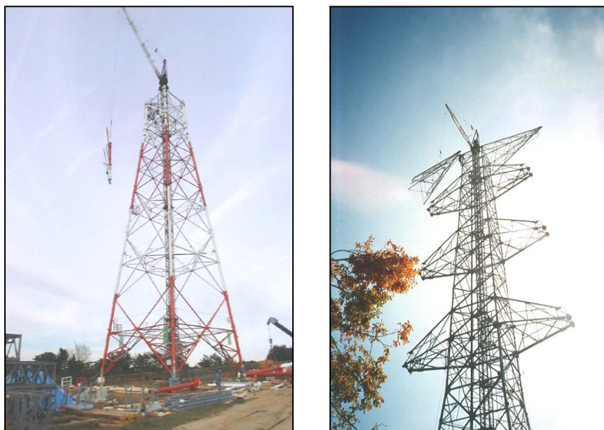
鉄塔工事－組立工事
