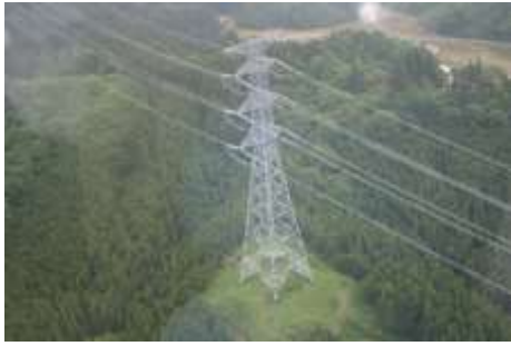
送電線を引っ張りあっている鉄塔
