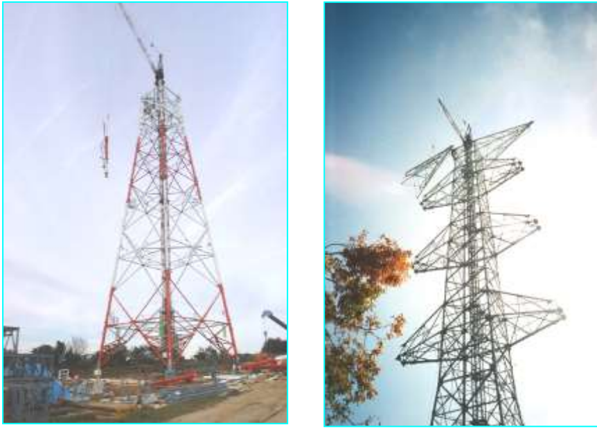
鉄塔工事－組立工事
