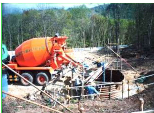
鉄塔工事－基礎工事
