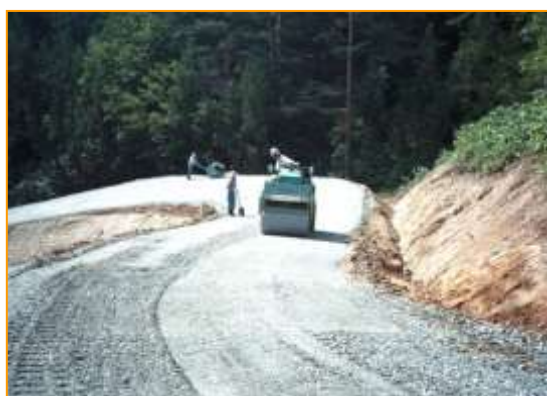
工事用運搬道路
