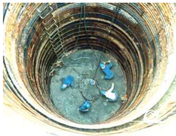
鉄塔工事－基礎工事
