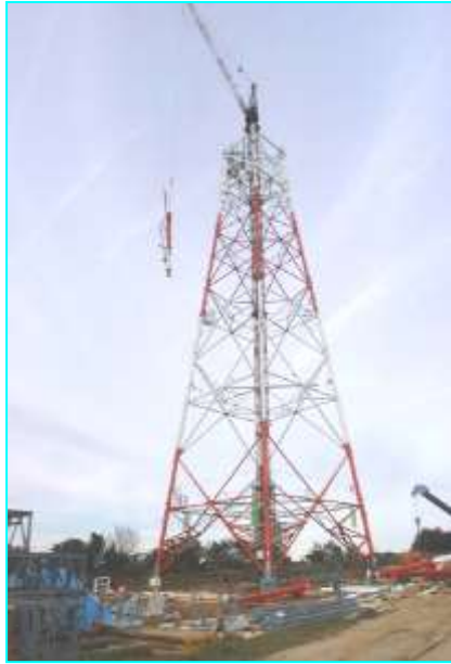
鉄塔工事—組立工事
