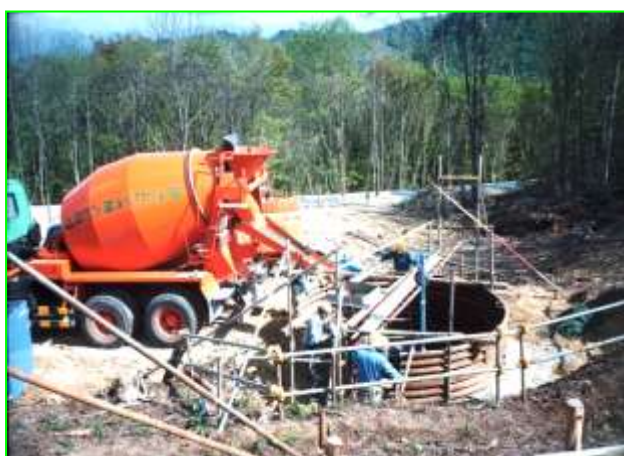
鉄塔工事－基礎工事
