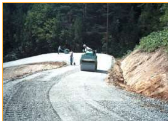
工事用運搬道路
