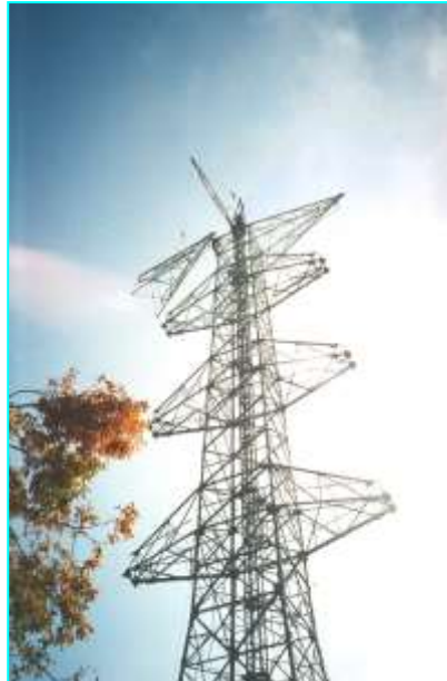
鉄塔工事—組立工事
