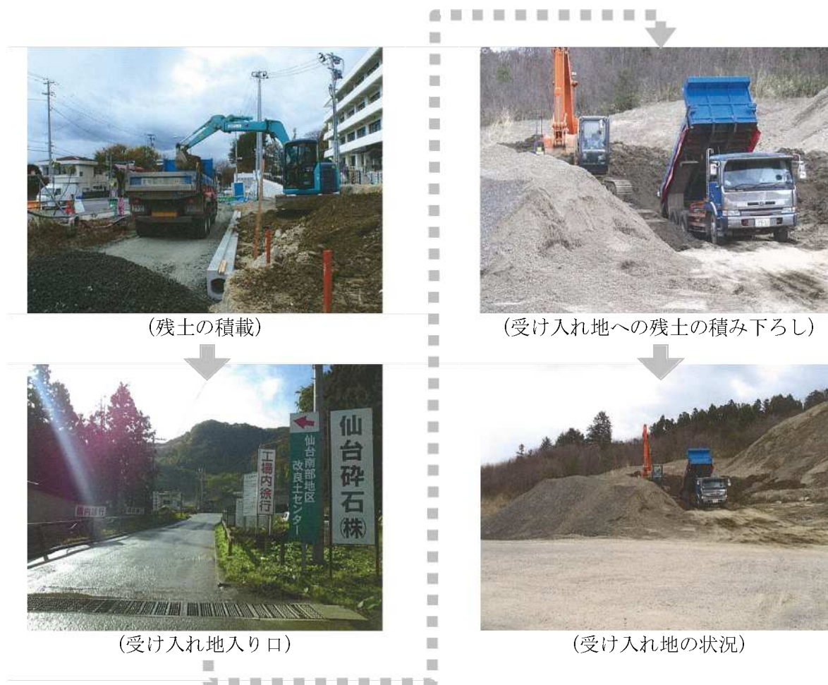
写真 6. 4. 2-1 残土の運搬及び受け入れ地の状況 ④
