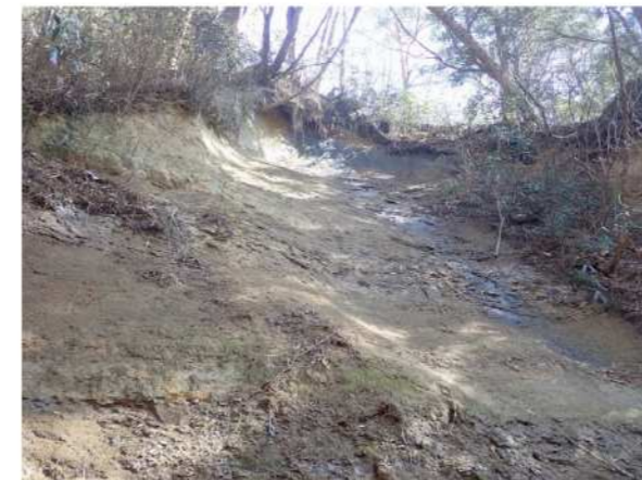
②右岸工事用地下端部の下 溪岸の状況 右岸斜面排水路より排水が行われているが、浸食等は生じていない。オーバーハングで不安定な地形だが前回調査 (H29.9.20) から新たな崩壊は発生していない。
