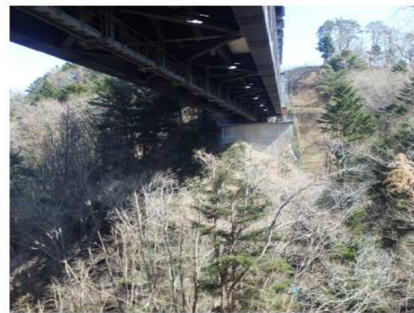
右岸工事箇所全景
