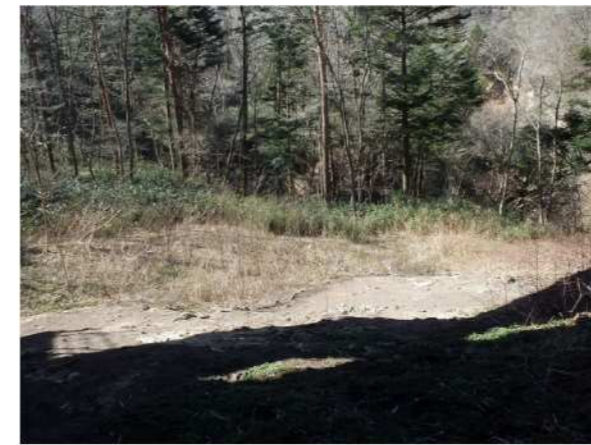
①右岸工事用地下端部 法面植生工箇所は枯れた植生が残存している。融雪に伴う新たな土砂の流出は認められない。(前回調査 H29.9.20 から変化無し)
