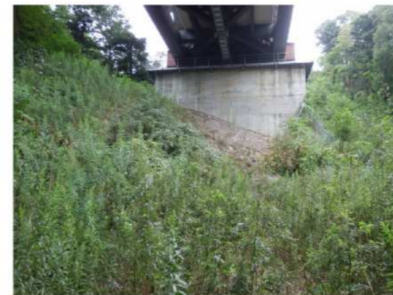
③右岸橋脚前面の状況 法面植生工箇所の植生が発達し、溪谷への土砂流出を防止している。但し、橋脚直下は、急傾斜地のため、周辺の法面と比べて植生が発達が遅い。(前回調査 H29.3.17 から大きな変化無し)
