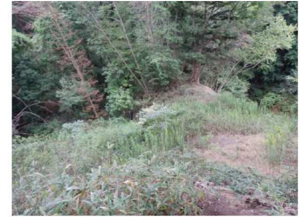
④左岸工事用地下端部 前回調査(H29.3.17)から法面植生工箇所のササ類等の植生が発達し、溪谷への土砂流出を防止している。
