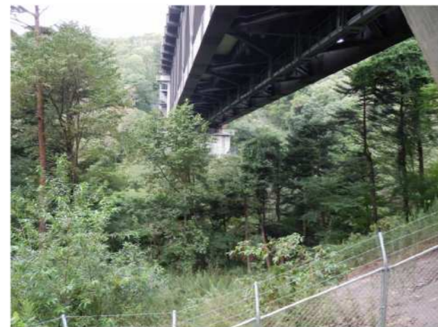
左岸工事箇所全景
