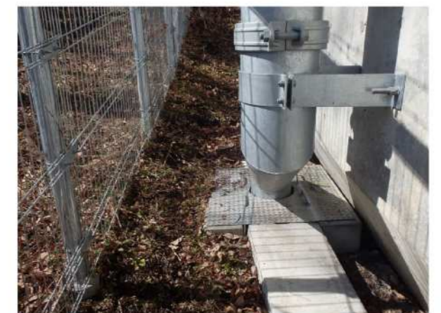
⑥左岸橋脚上流側面 排水路周辺斜面は法面植生工箇所の植生が発達し、溪谷への土砂流出を防止している。(前回調査 H29.9.20 から変化無し)
