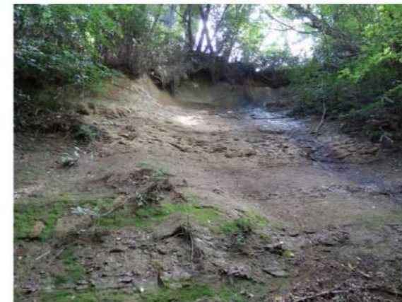
②右岸工事用地下端部の下 溪岸の状況 右岸斜面排水路より排水が行われているが、浸食等は生じていない。オーバーハングで不安定な地形だが前回調査(H29.3.17)から新たな崩壊は発生していない。
