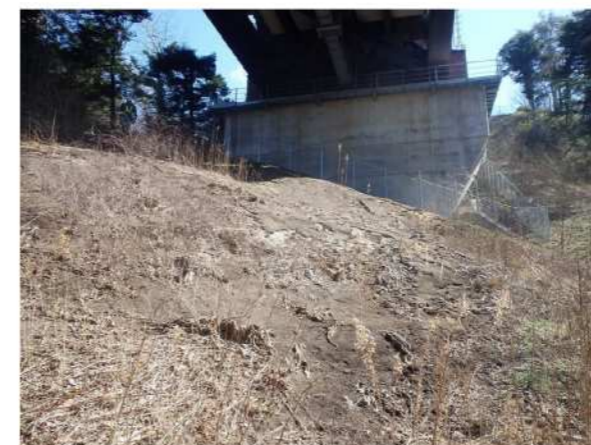
③右岸橋脚前面の状況 法面植生工箇所は枯れた植生が残存している。融雪に伴う新たな土砂の流出は認められない。(前回調査 H29.9.20 から変化無し)
