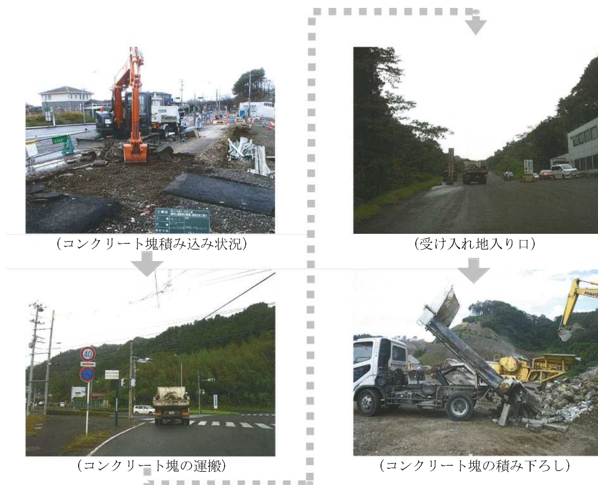
写真 6. 4. 1-1 コンクリート塊の運搬及び受け入れ地の状況 ③
