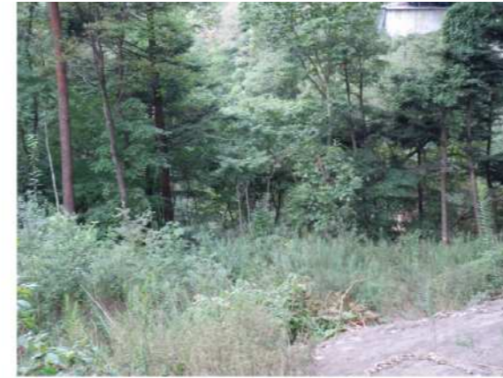
①右岸工事用地下端部 法面植生工箇所の植生が発達し、溪谷への土砂流出を防止している。(前回調査 H29.3.17 から大きな変化無し)
