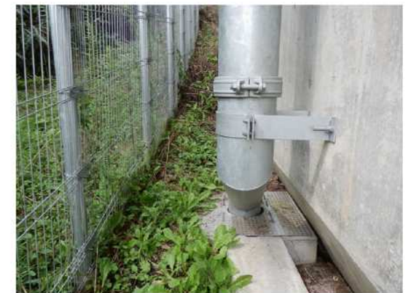
⑥左岸橋脚上流側面 前回調査(H29.3.17)から排水路周辺斜面の法面植生工箇所の植生が発達し、溪谷への土砂流出を防止している。
