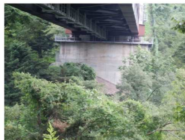
右岸工事箇所全景
