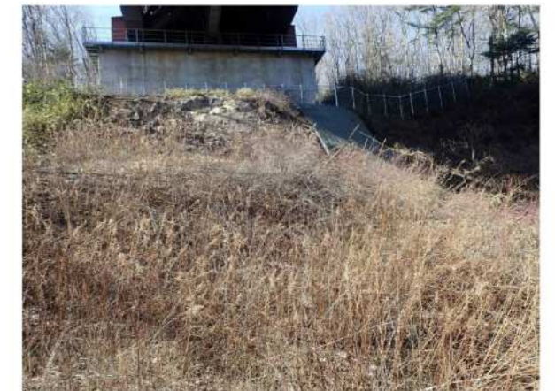
⑤左岸橋脚前面の状況 法面植生工箇所は枯れた植生が残存しており、表層のガリー浸食*1による土砂流出を防止している。(前回調査 H29.9.20 から変化無し)
