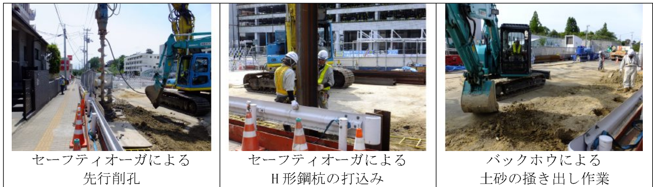
写真 6. 1. 1-1 重機の稼動状況
