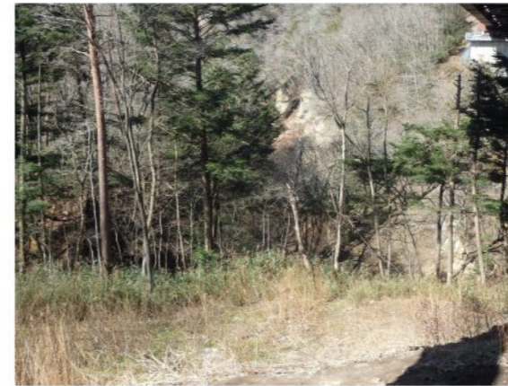
①右岸工事用地下端部 法面植生工箇所の植生が発達し、溪谷への土砂流出を防止している。(前回調査 H28.8.25 から変化無し)
