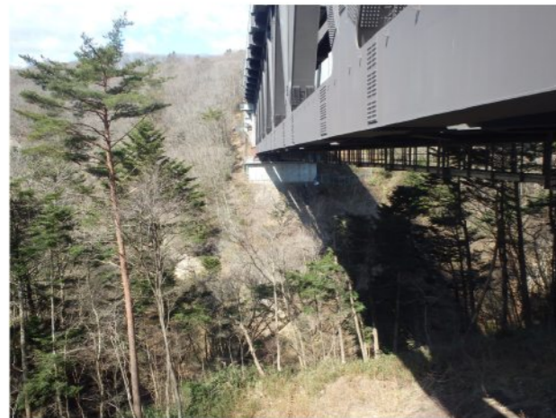
左岸工事箇所全景
