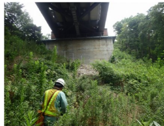
③ 右岸橋脚前面の状況 前回調査 (H28.3.8) から法面植生工箇所の植生が発達し、溪谷への土砂流出を防止している。但し、橋脚直下は、急傾斜地のため、周辺の法面と比べて植生の発達が遅い。
