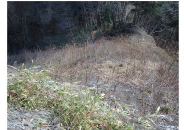
④左岸工事用地下端部 法面植生工箇所の植生が発達し、溪谷への土砂流出を防止している。(前回調査 H28.8.25 から変化無し)
