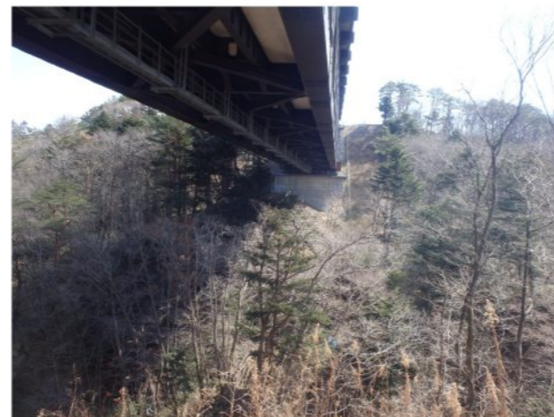
右岸工事箇所全景
