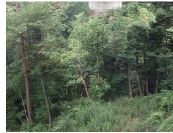
① 右岸工事用地下端部 前回調査 (H28.3.8) から法面植生工箇所の植生が発達し、溪谷への土砂流出を防止している。
