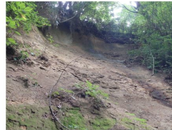
② 右岸工事用地下端部の下 溪岸の状況 右岸斜面排水路より排水が行われているが、浸食等は生じていない。オーバーハングで不安定な地形だが前回調査 (H28.3.8) から新たな崩壊は発生していない。
