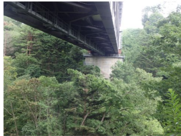
右岸工事箇所全景
