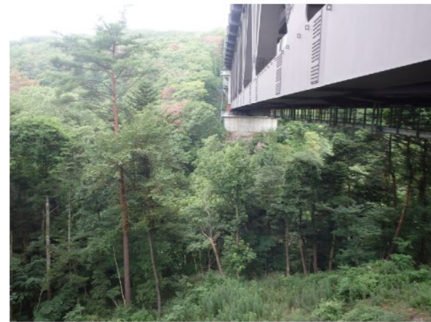
左岸工事箇所全景
