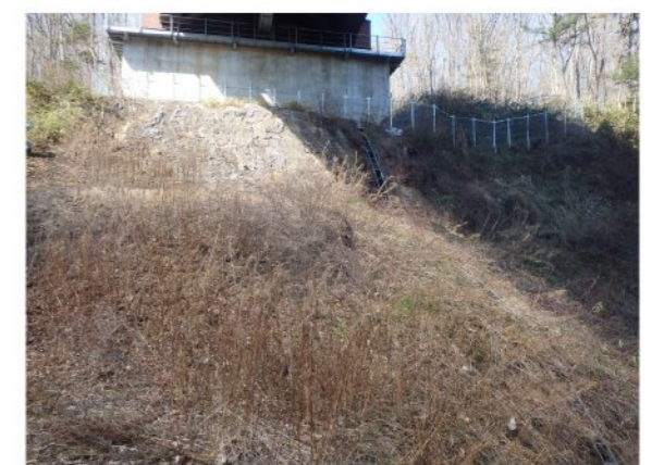
⑤左岸橋脚前面の状況 法面植生工箇所の植生が発達し、表層のガリー浸食 ※1 による土砂流出を防止している。但し、橋脚直下は、急傾斜地のため、周辺の法面と比べて植生の発達が遅い。(前回調査 H28.8.25 から変化無し)
