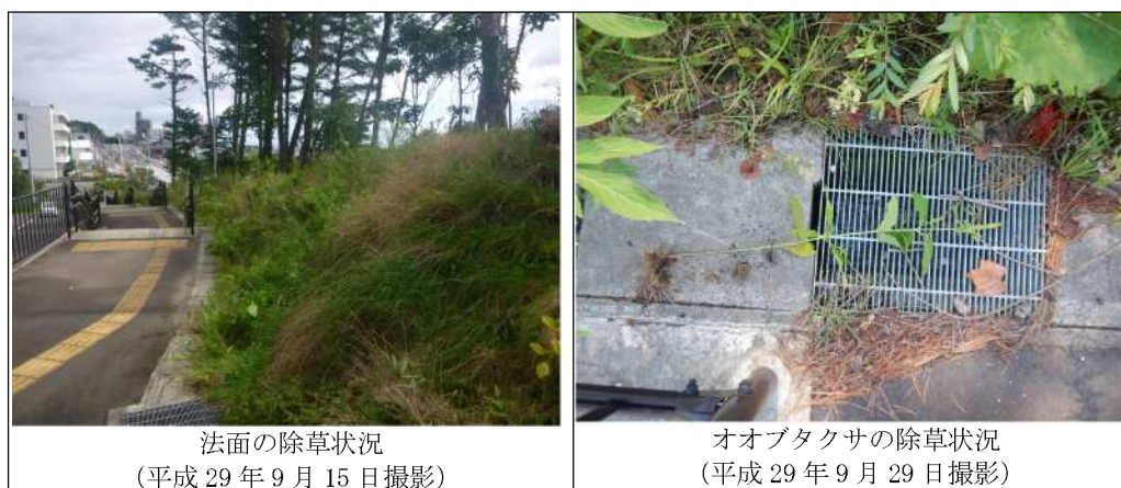
写真 4.2-4 重点対策外来種の除草作業の状況
