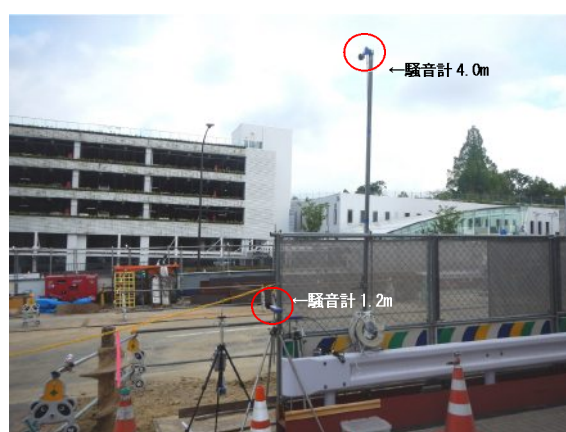
写真 5.2.1-1 測定機器設置状況
