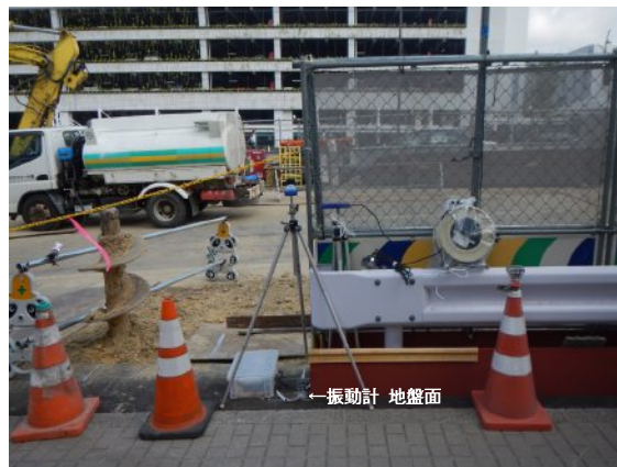
写真 5.2.2-1 測定機器設置状況
