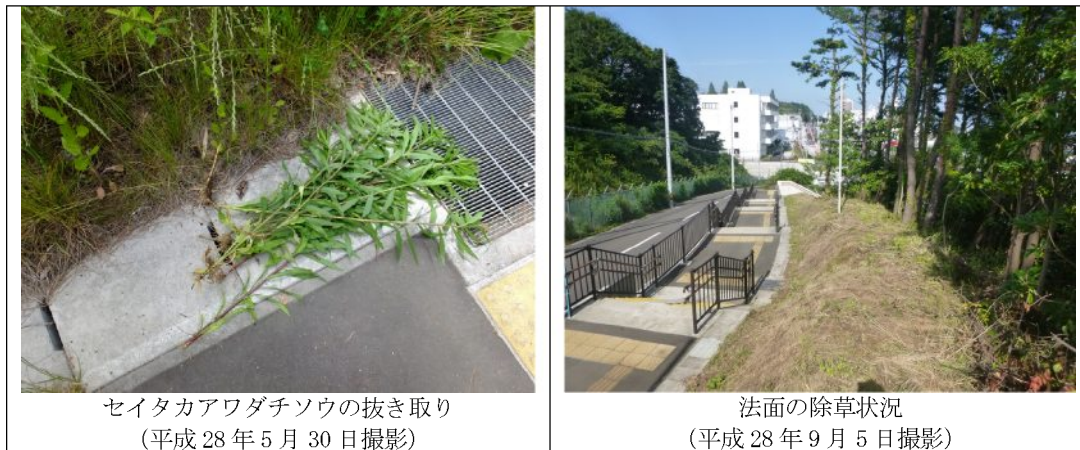
写真 4. 2. 2-3 重点対策外来種の除草作業の状況
