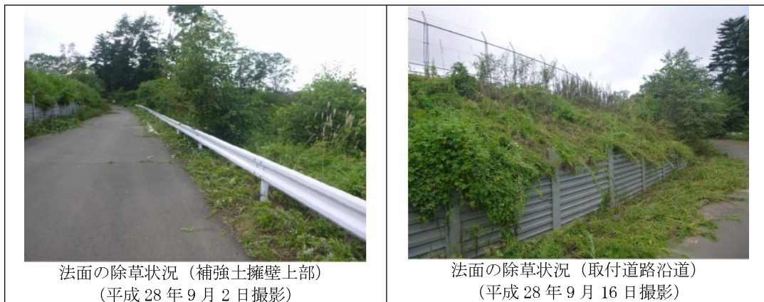
写真 4.2.2-1 重点対策外来種の除草作業の状況
