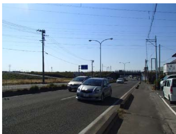
④ 主要地方道仙台松島線(山崎交差点付近)
