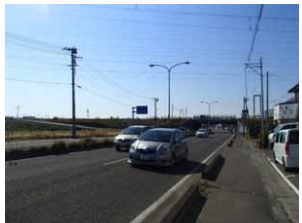
主要地方道仙台松島線(山崎交差点付近)
