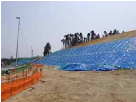
写真 8.1-1 追加保全対策実施状況（ブルーシートによる被覆）
