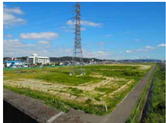
No.6 国道4号跨線橋（北方向）
