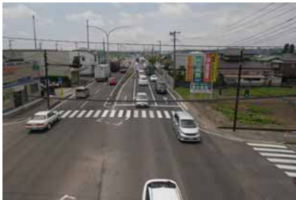
No.3 岩切歩道橋（南方向）
