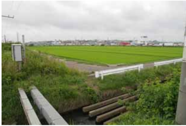
No.1 大井川踏切（西方向）
