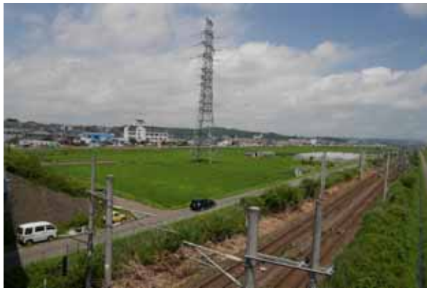
No.8 国道4号跨線橋
