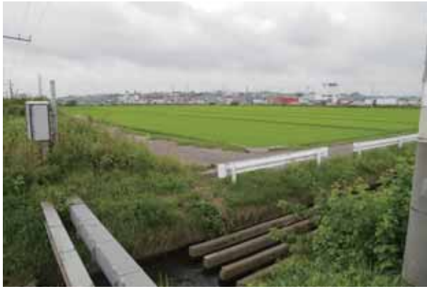
No.1 大井川踏切 (西方向)
