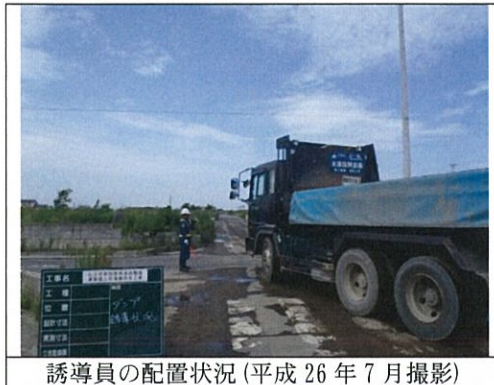
写真 8. 6-4 誘導員の配置状況（荒浜工区（その1））
