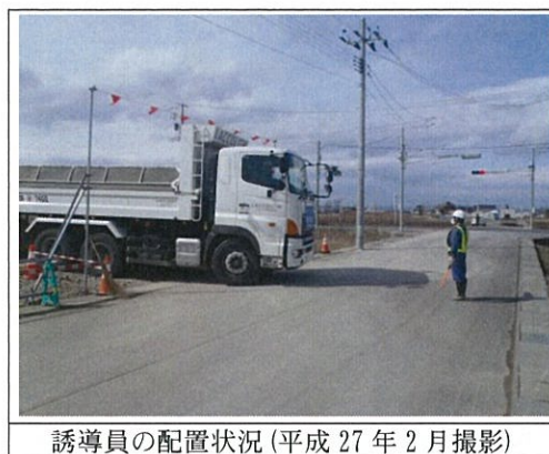
写真 8. 6-5 誘導員の配置状況（井土工区（その1））
