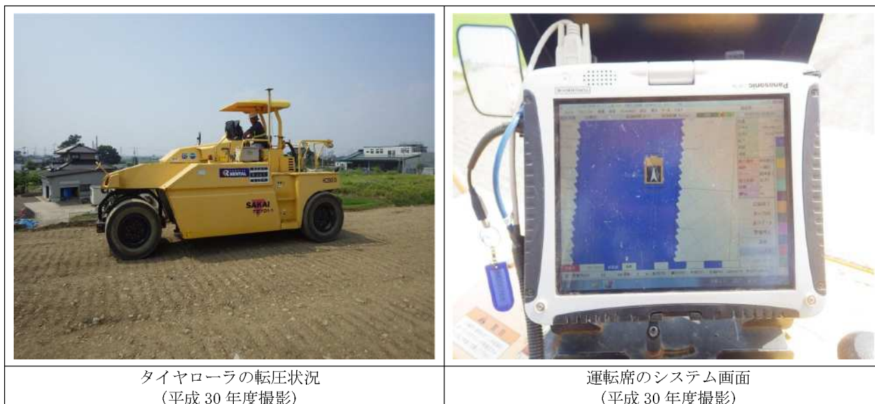
写真 8-24 転圧管理システムによる施工状況
