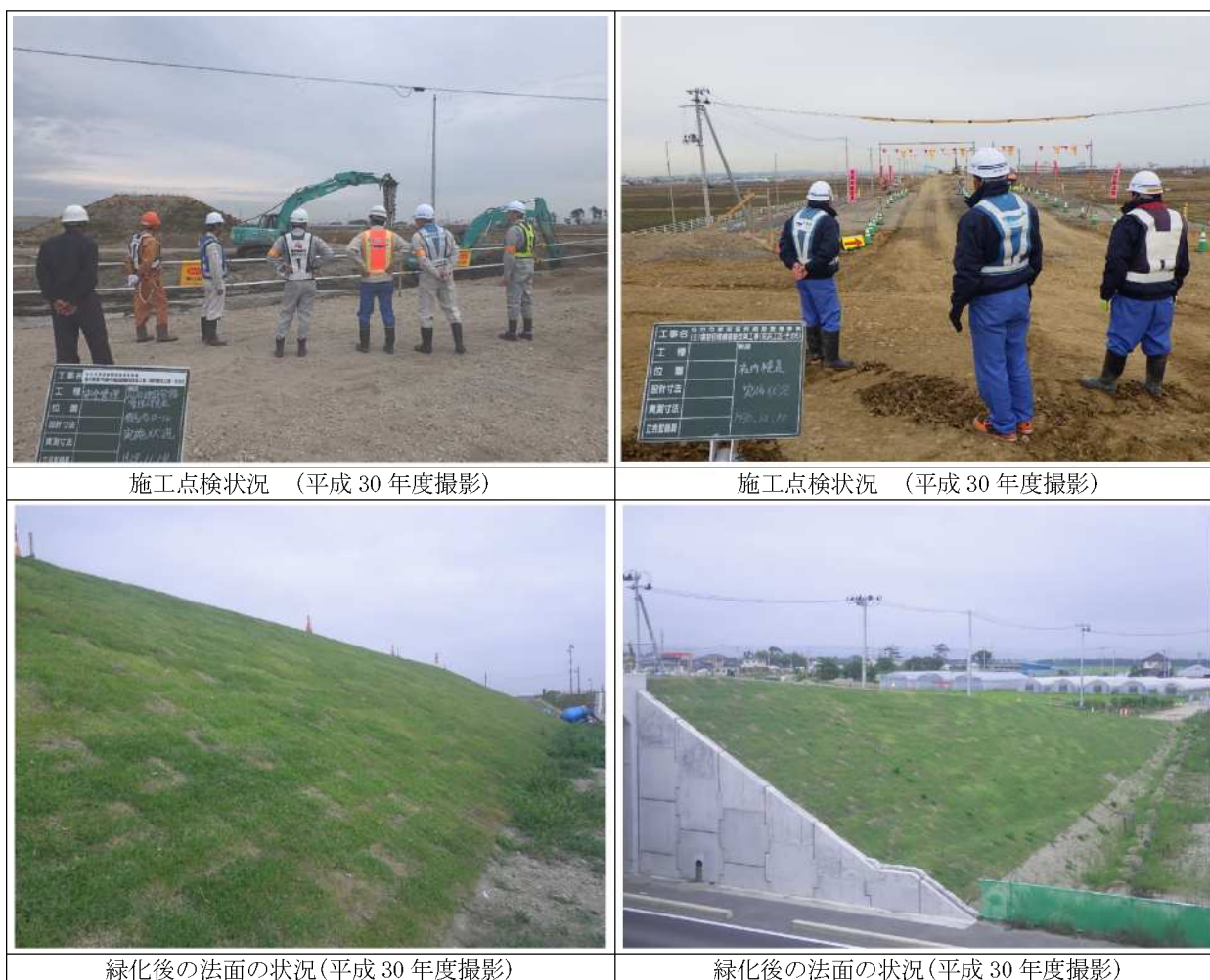
写真 8-1 盛土法面の点検状況
