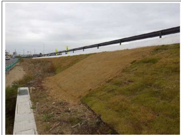
法面の復旧状況（令和元年10月18日撮影）
