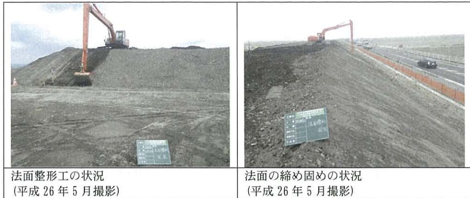
写真 6-5 法面の締め固めの状況
