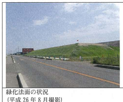
写真 6-4 緑化法面の状況
