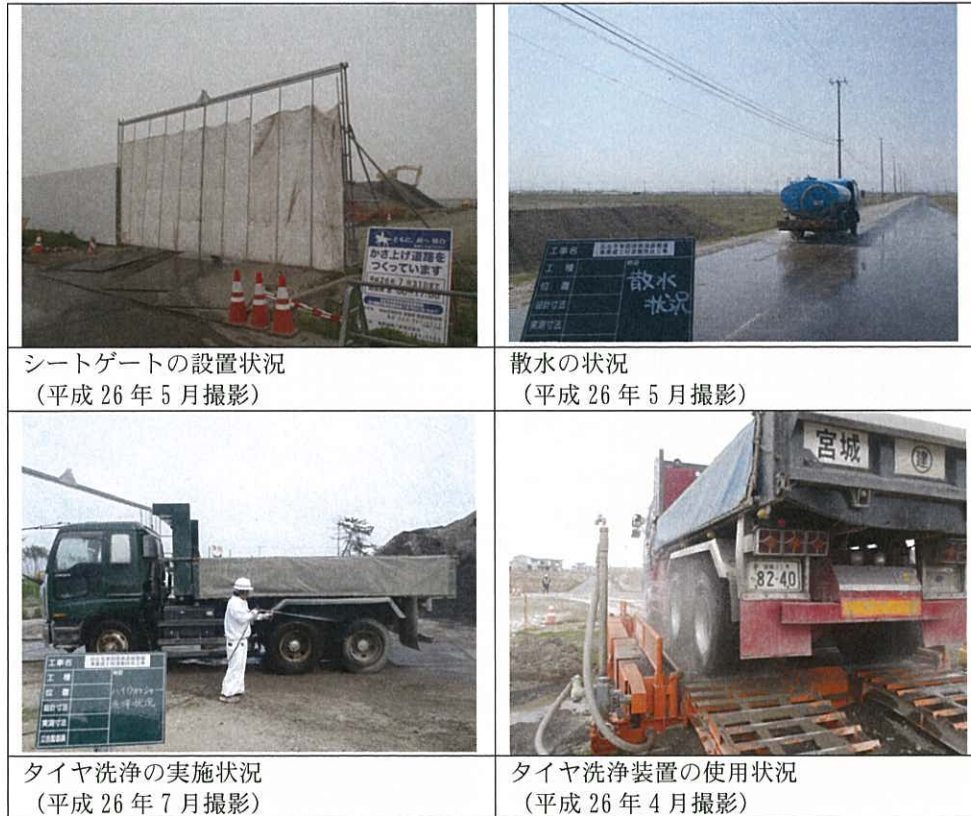
写真 6-3 粉じん対策の実施状況
