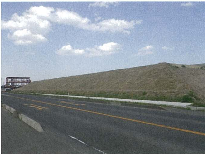
写真 2.6-3 緑化後の状況（平成 27 年 4 月 25 日）
