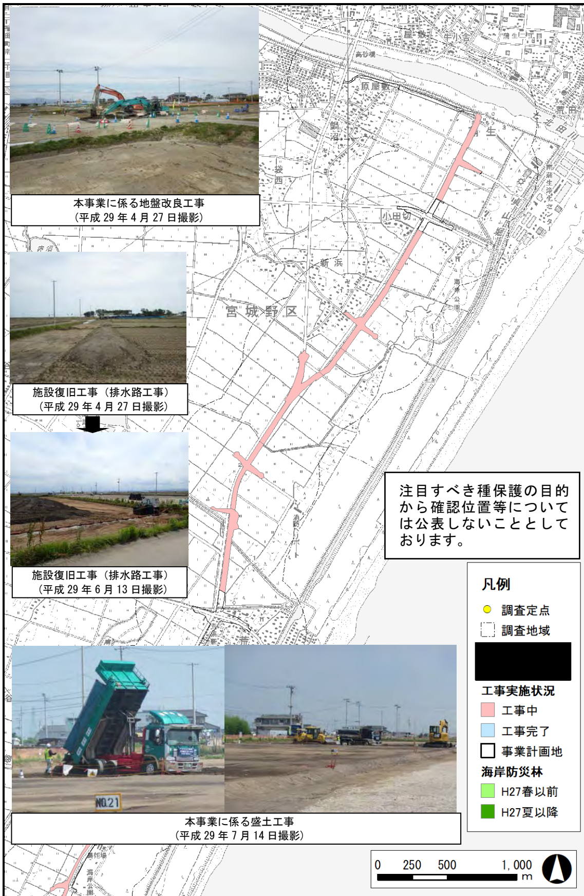
図 9.1-5 オオタカの盛土工事の実施状況 (盛土工事)
