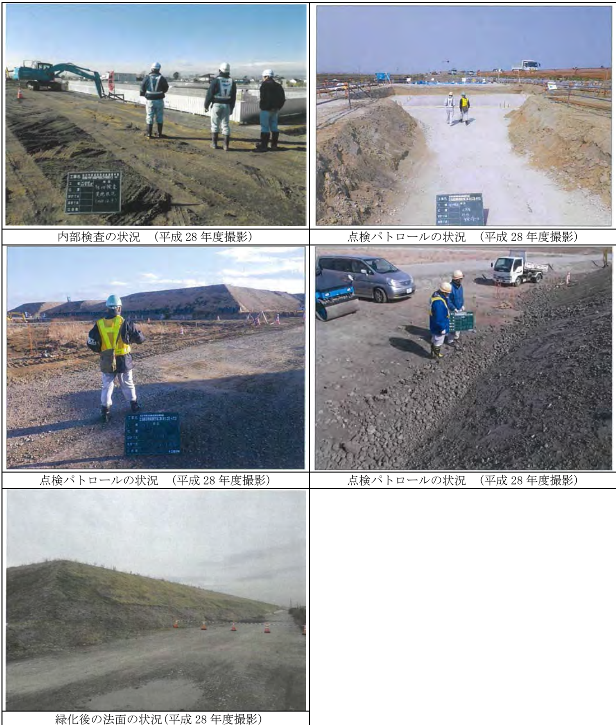
写真 8.5-1 盛土法面の点検状況
