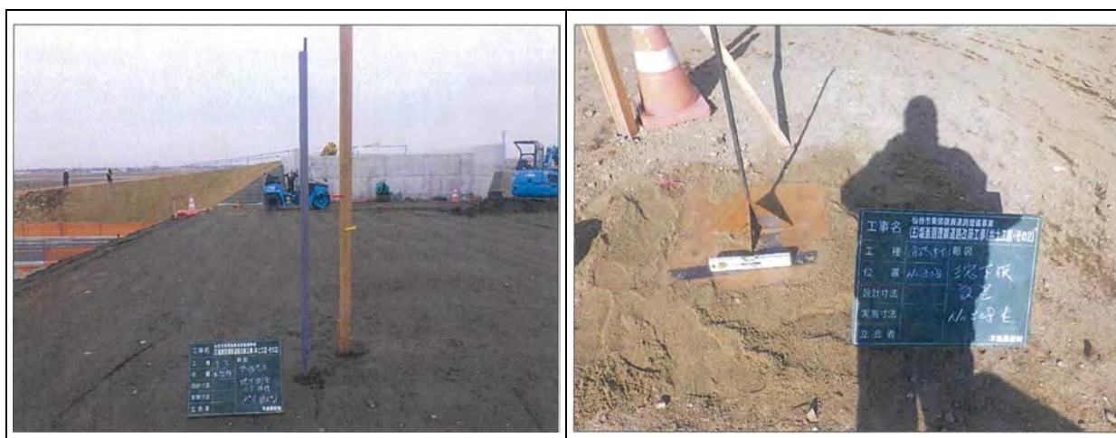
写真 7.7-1 沈下板の設置状況 (平成 28 年度撮影)
