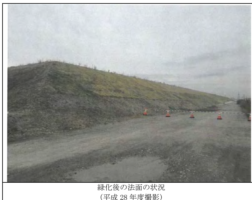
写真 6-4 緑化後の法面の状況
