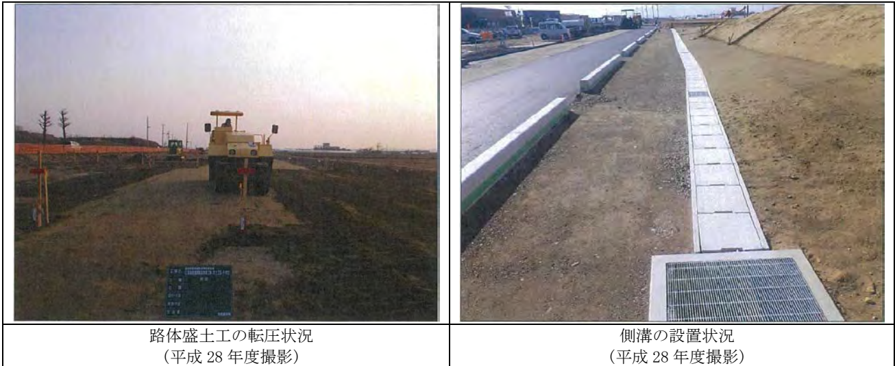
写真 6-5 盛土の締め固めの状況及び側溝の設置状況
