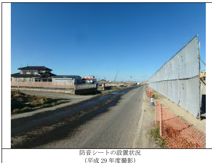
写真 6-3 防音シートの設置状況
