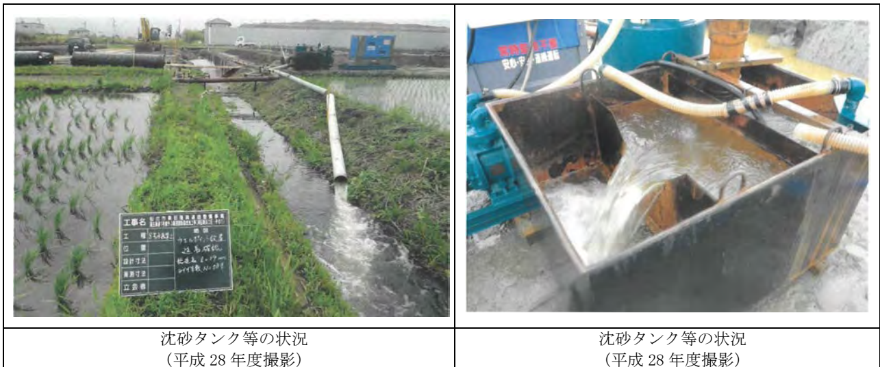
写真 6-6 沈砂タンク等の設置状況
