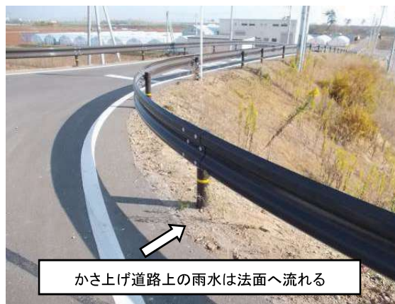
写真 9.1-2 かさ上げ道路の法面
