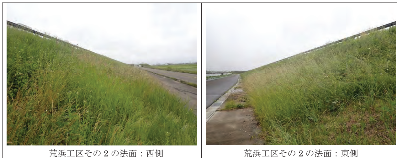
写真 8.3-2 荒浜工区（その2）の法面の状況
