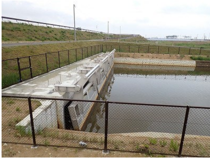
写真 2.5-1 フラップゲートの設置状況（二郷堀）
