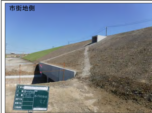
動物の移動経路の設置状況（施工中） （平成 30 年度撮影）
