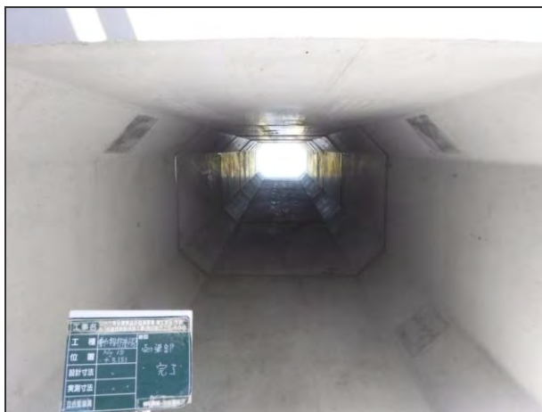
動物の移動経路の設置状況（施工中） （平成 30 年度撮影）
