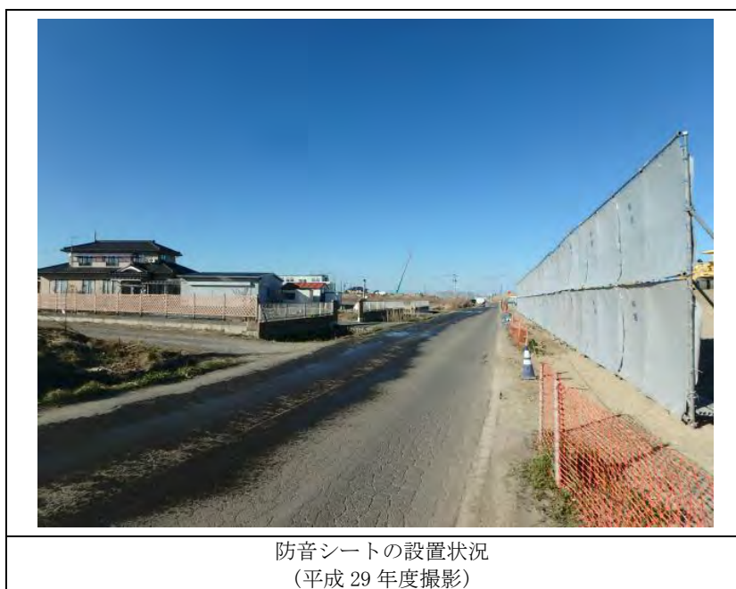
写真 6-3 防音シートの設置状況
