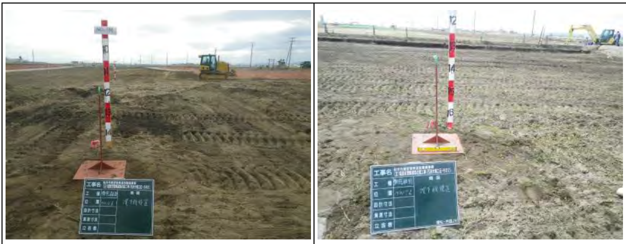
写真 7.3-1 沈下板の設置状況 (平成 29 年度撮影)
