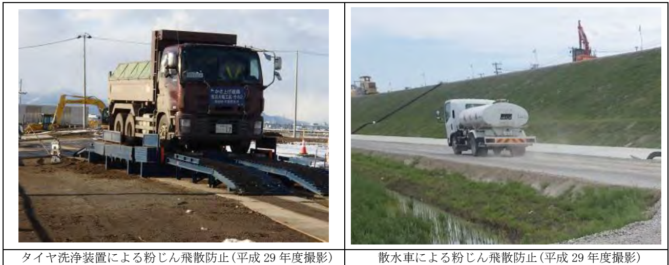
写真 6-2 粉じんの飛散防止対策の実施例
