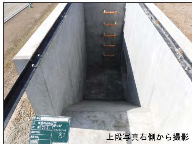
動物の移動経路の設置状況（施工中） （平成 30 年度撮影）
