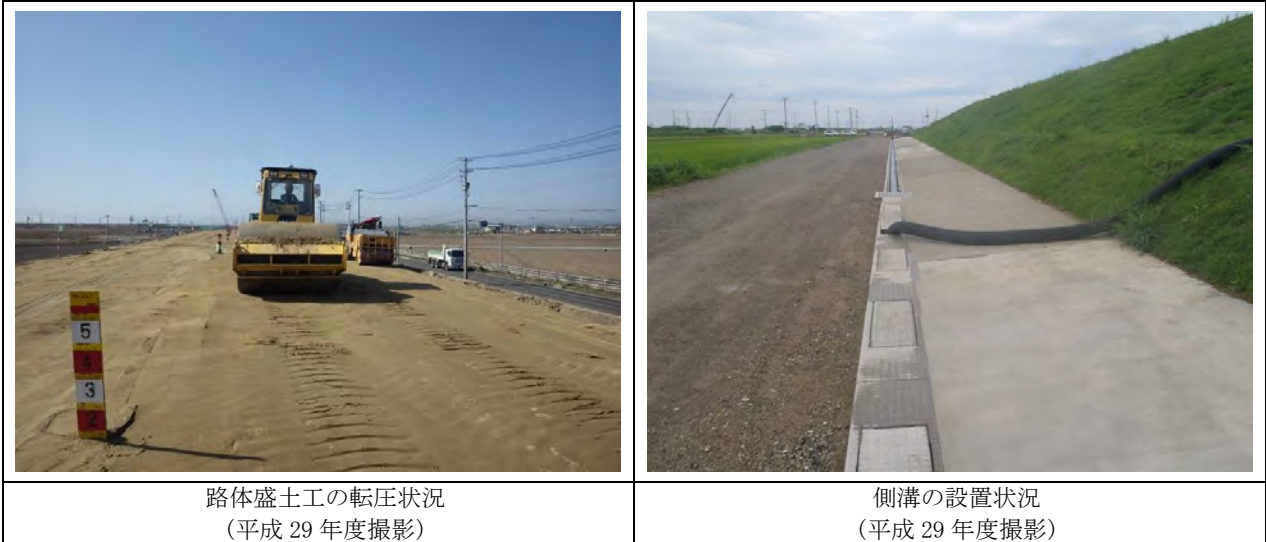
写真 6-5 盛土の締め固めの状況及び側溝の設置状況
