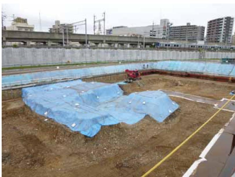
写真 9.7-2 汚染土壌養生状況（平成 24 年 5 月撮影，撮影方向は図 9.6-2 に示す）
