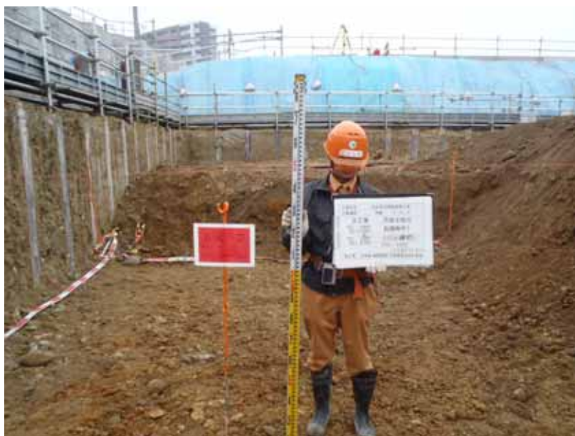
写真 9.7-1 汚染土壌掘削管理状況（平成 24 年 4 月撮影，撮影方向は図 9.6-2 に示す）
