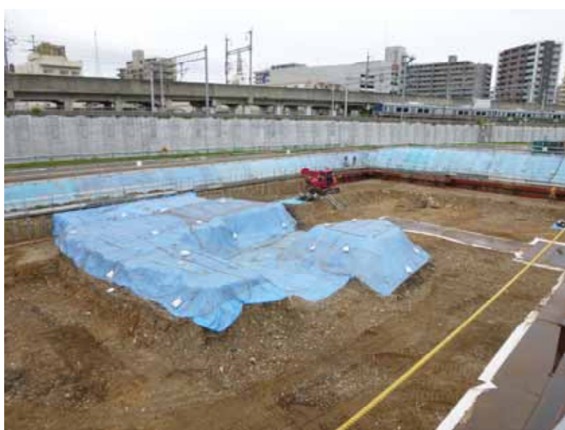
写真 9.7-2 汚染土壌養生状況（平成 24 年 5 月撮影，撮影方向は図 9.6-2 に示す）
